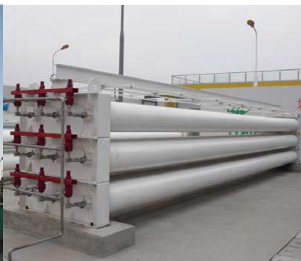
图 2 无缝管式储气瓶储氢装置
